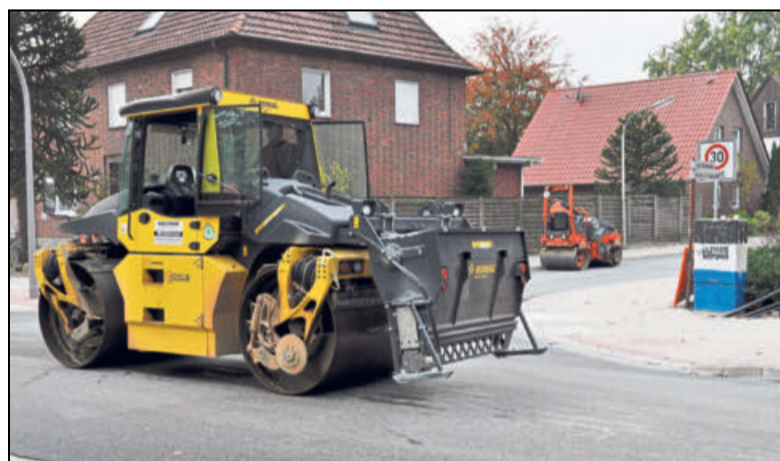
Mit den Walzen wird hier die dritte Asphaltdecke verdichtet. Anfang nächster Woche wird die Straße wieder freigegeben. Fotos: Christ
